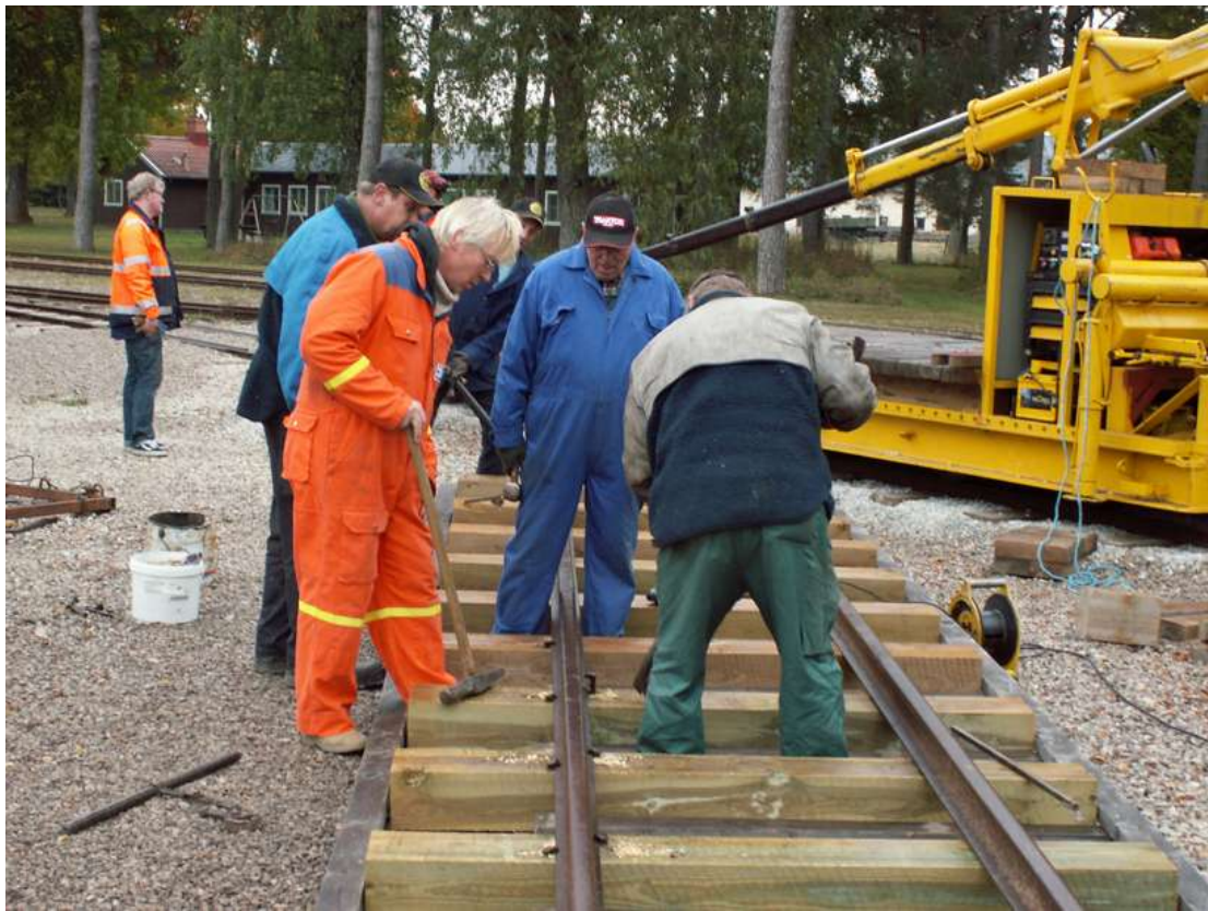
Två räslängder, 12 slippers samt 48 spik åtgår till varje tiometerssektion
