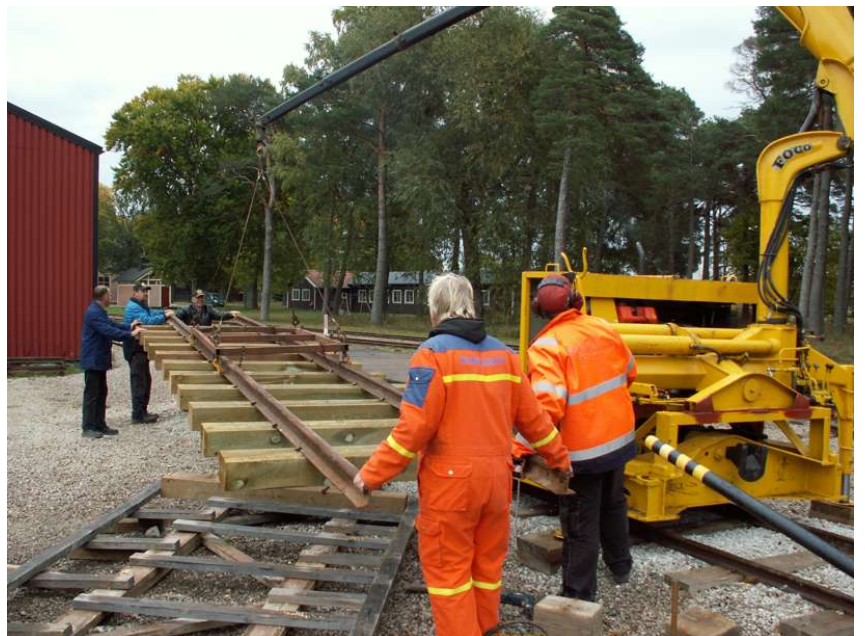
En färdigtillverkad sektion lyfts ur jiggen och ombord på arbetsvagnen
